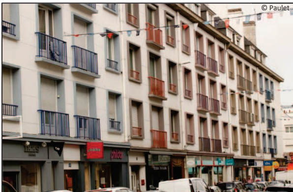
Figure 54 : Immeuble rue de Liège dans le centre-ville de Lorient (2020)
