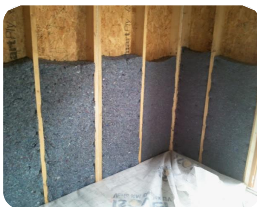
Figure 3-2. Isolation des parois par 15 cm de Métisse®
