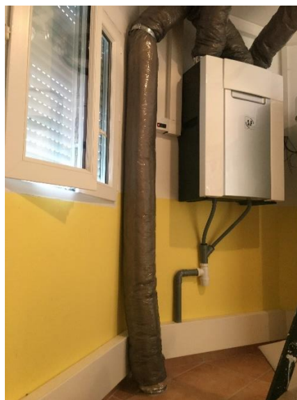
Figure 3-7. VMC DF du bâtiment
