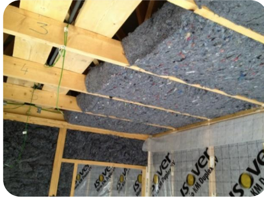
Figure 3-3. Isolation du plafond par 20 cm de Métisse®
