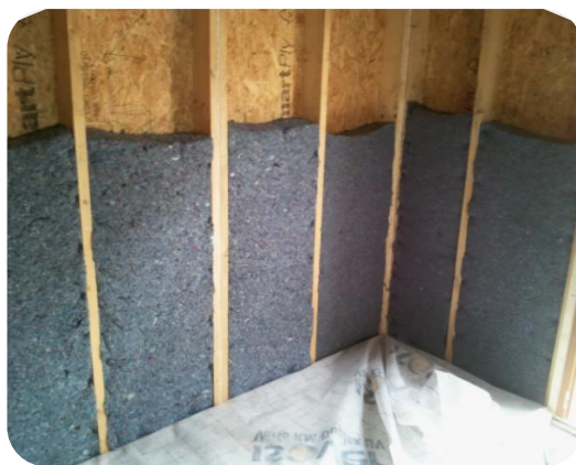
Figure 3-2. Isolation des parois par 15 cm de Métisse®
