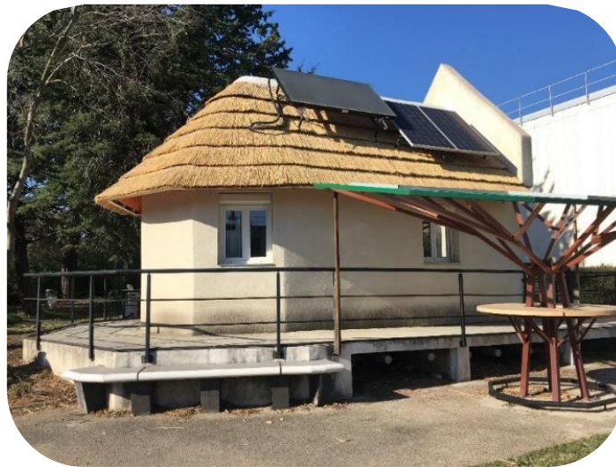
Figure 3-1. Le bâtiment expérimental
