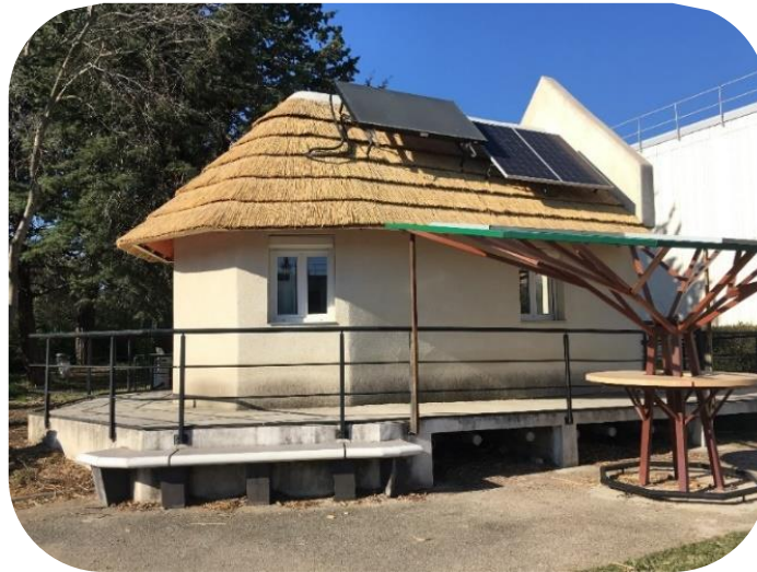
Figure 3-1. Le bâtiment expérimental
