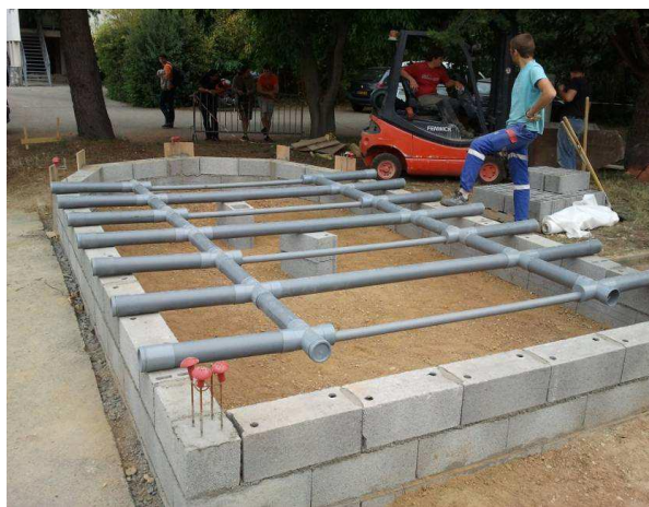
Figure 3-5. Installation du puits thermique en 2011
