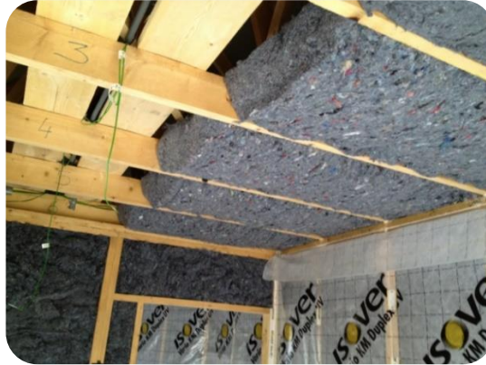
Figure 3-3. Isolation du plafond par 20 cm de Métisse®
