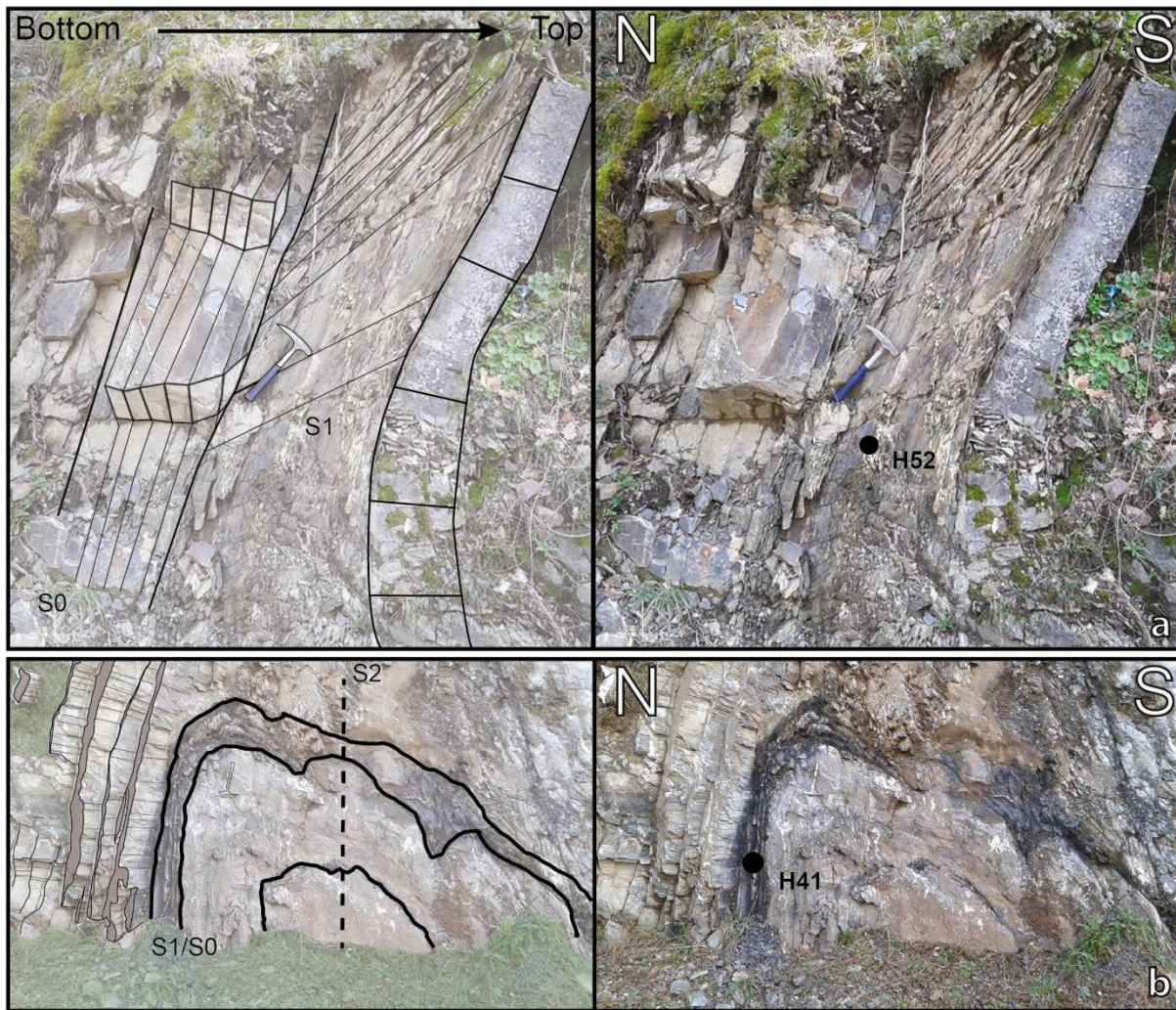
Figure 39 : Photos montrant les deux principales phases de déformation dans le flanc sud de la Montagne Noire. (a). Flanc inversé verticalisé d'un pli contemporain des plis couchés à l'échelle du km (F1), près de Ferrals-les-Montagnes. L'échantillon H52 a été prélevé pour l'étude RSCM. (b). Pli droit de plan axial vertical responsable d'une schistosité (S2) contemporain du dôme de la zone axiale (F2) et localisation de l'échantillon H41, à proximité de St-Pons. Les couches plissées forment la surface S0-S1 où (S1) et sont contemporaines des plis couchés (F1).
