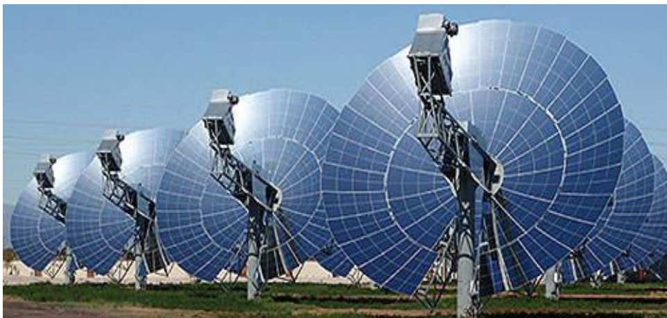
Figure 4 : Photographie de la centrale Dish Stirling Maricopa située en Arizona aux États-Unis (11).
