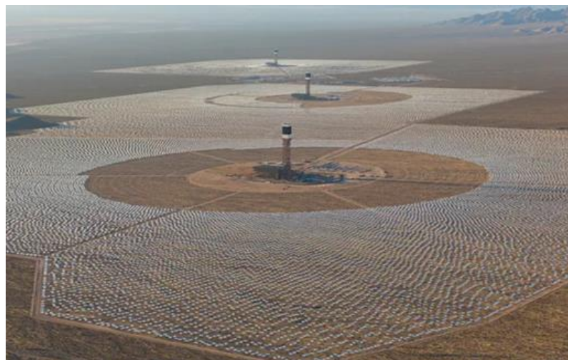
Figure 3 : Photographie de la centrale à tour Ivanpah située en Californie aux États-Unis (9).
