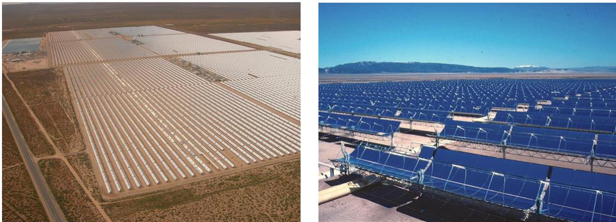
Figure 5 : Photographie aérienne et vue au sol de la centrale cylindro-parabolique SEGS (Solar Energy Generating Station) située en Californie aux États-Unis (12).
