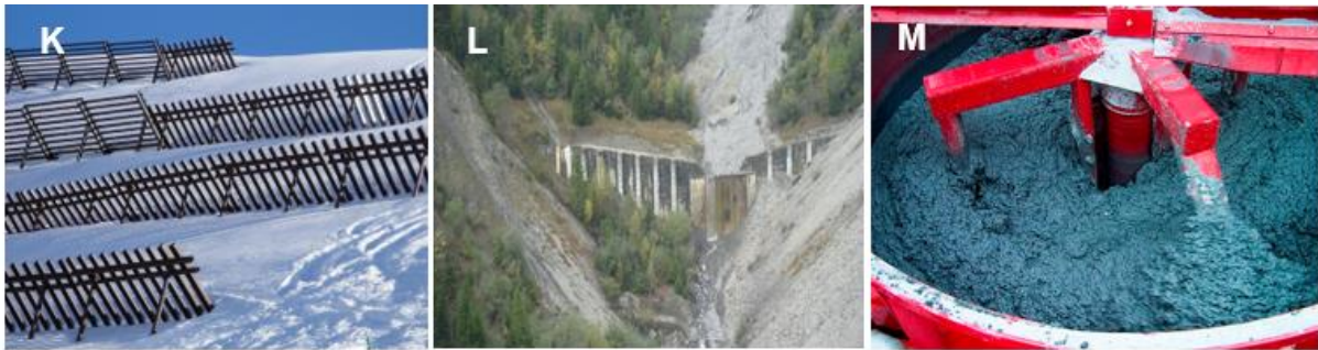
Figure 2: Exemples d'écoulement d'un fluide à seuil autour d'un obstacle, (K) système de prévention contre les avalanches, (L) barrière de protection contre les laves torrentielles, (M) mélange du béton, tirés de [5].
