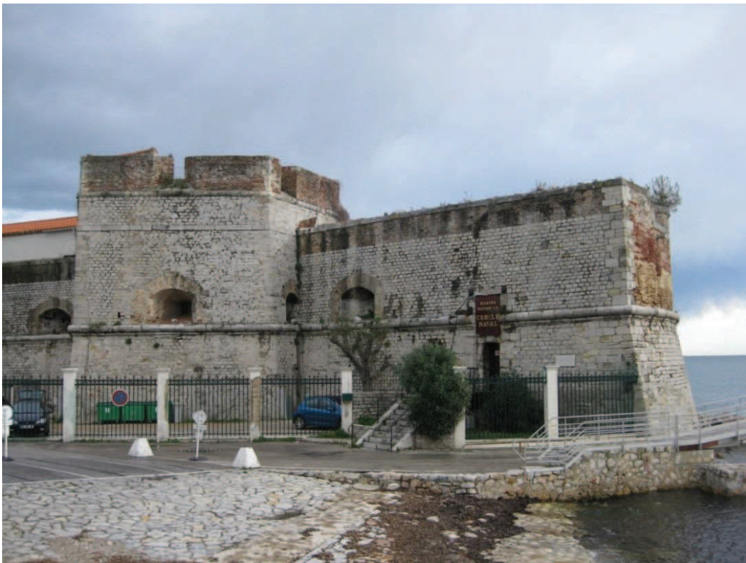
Figure 28 Le front d'eau du Mourillon et la Tour Royale
