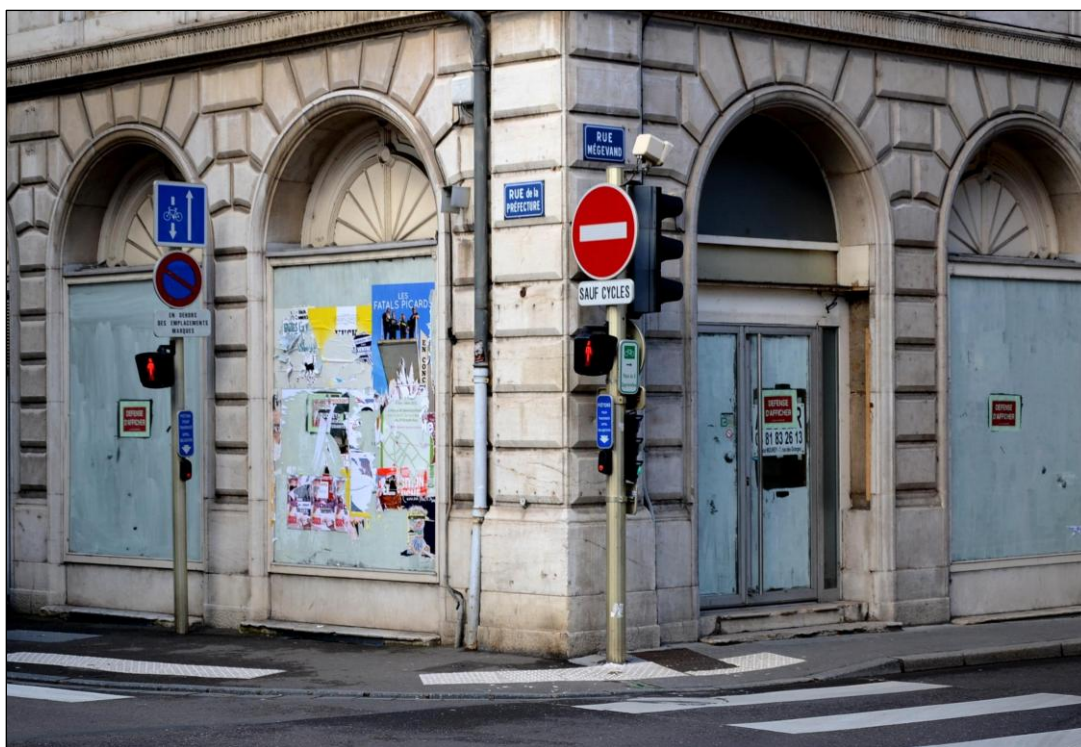
Photographie prise à l'angle de la rue Mégevand et de la rue de la Préfecture fin février 2014 – ancienne agence Crédit Agricole (photo : Jeremy Cardot)
