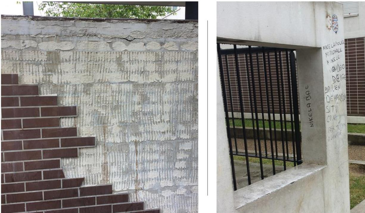
Figure 34. Des exemples de dégradations : un mur dégradé (parements décollés) et un mur tagué.
