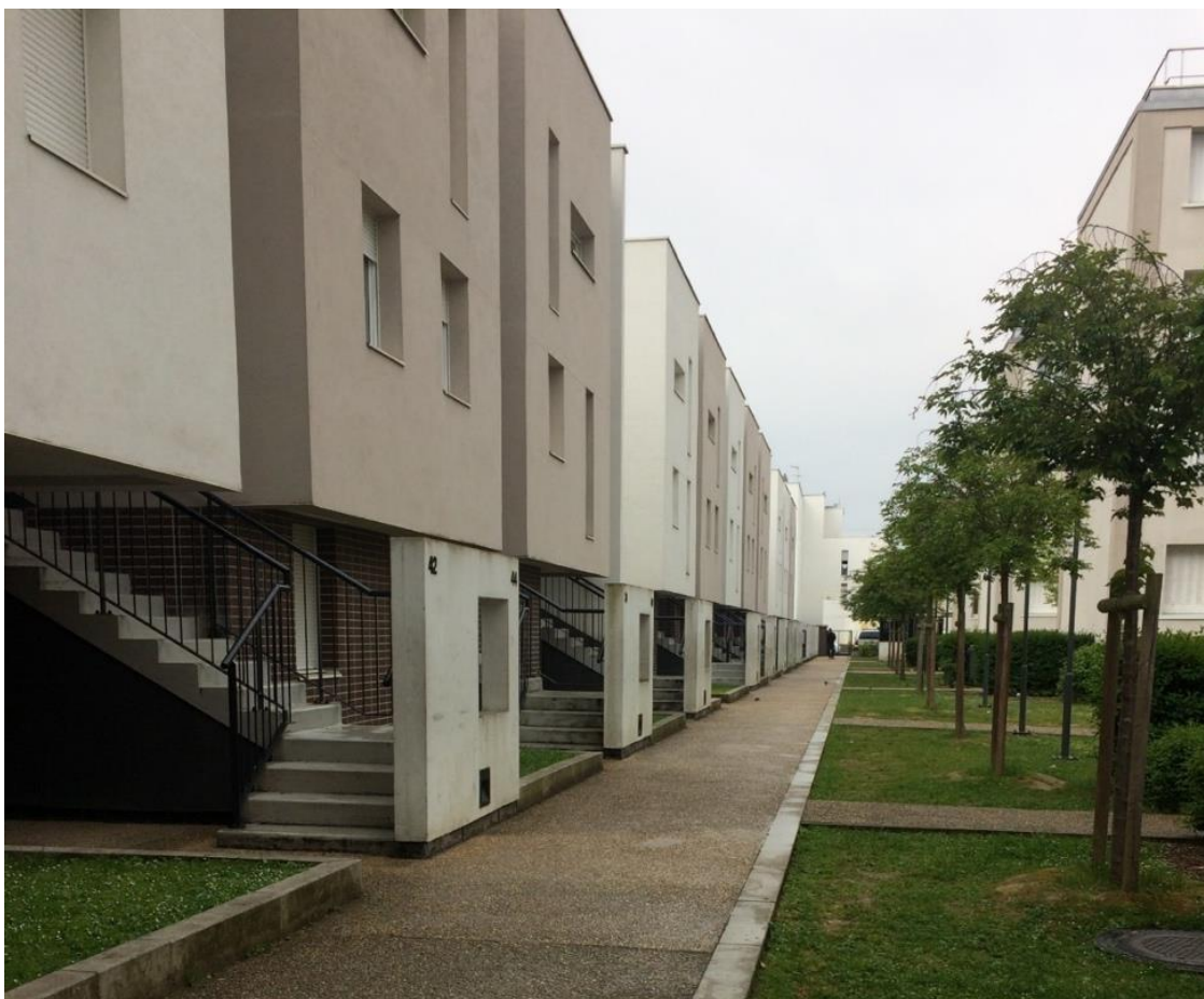
Figure 16. Une ancienne barre redécoupée en plus petits immeubles : multiplier les contrôles d'accès et favoriser un sentiment de privatisation de la résidence. Source : A. Mille, avril 2017 (bailleur enquêté, Yvelines).
