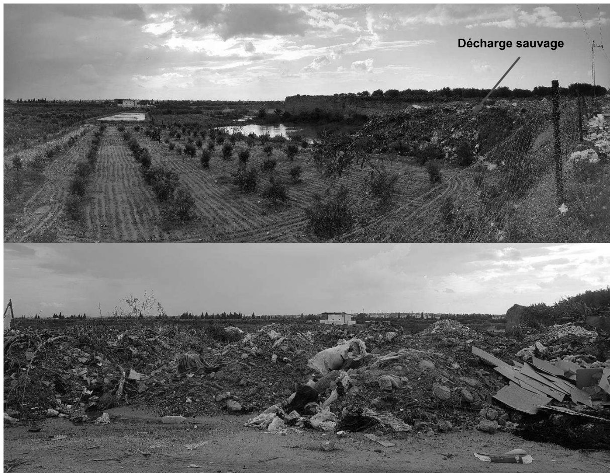
Figure 47: l'installation d'une décharge sauvage dans le PPI de Sahline (Cliché : R.SLAMA, novembre 2019)
