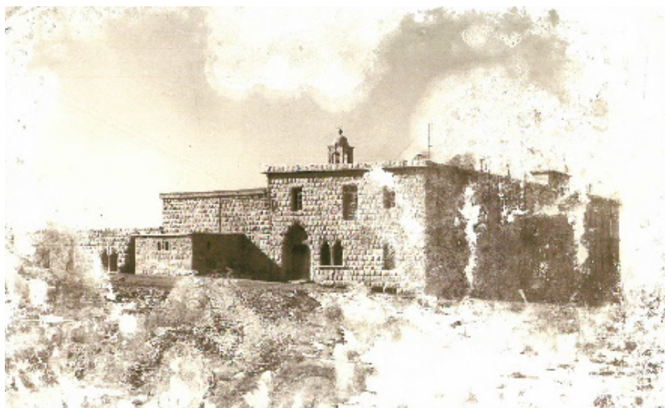
Figure n° 26 : Le passé et le présent : Un patrimoine bâti
