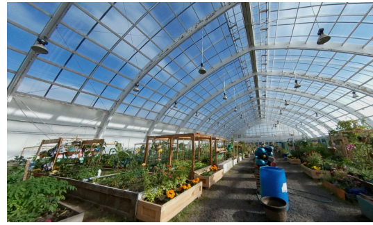
FIGURE 2.7 – Vue intérieure de la serre d'Inuvik [37]
