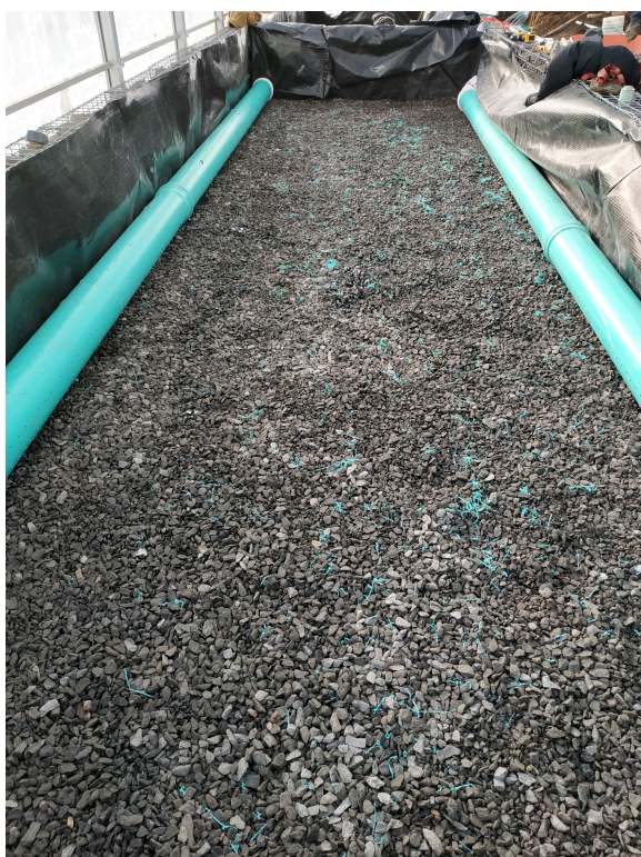
FIGURE 4.13 – Positionnement des tuyaux
