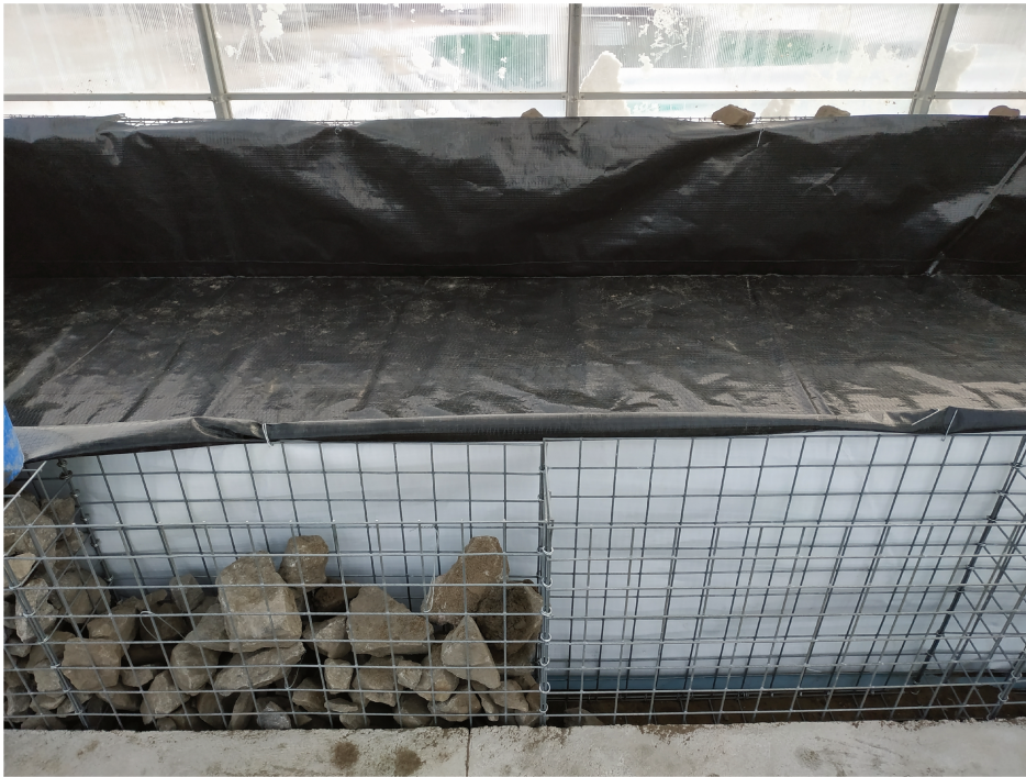
FIGURE 4.5 – Photo d'un pan de gabion installé dans la serre de Kuujjuaq
