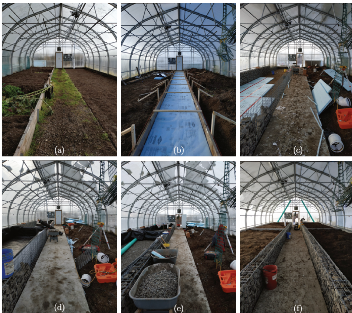
FIGURE 4.8 – Les différentes étapes de construction du système de stockage de la chaleur
