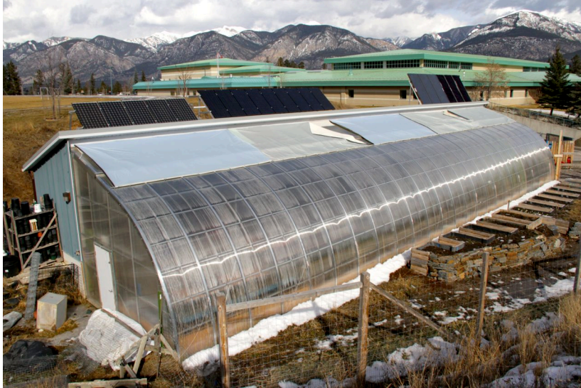
FIGURE 2.9 – Vue extérieure de la serre d’Invermere [48]
