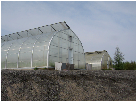
FIGURE 2.2 – Vue extérieure des serres de Kuujjuaq 1
