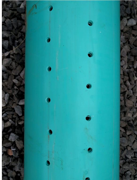
FIGURE 4.10 – Perçage d'un tuyau en PVC
