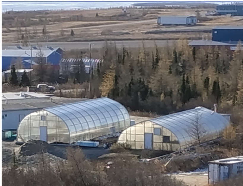
FIGURE 3.2 – Vue extérieure des serres de Kuujjuaq
