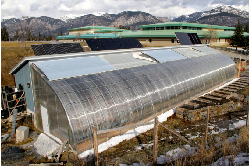
FIGURE 2.9 – Vue extérieure de la serre d’Invermere [48]
