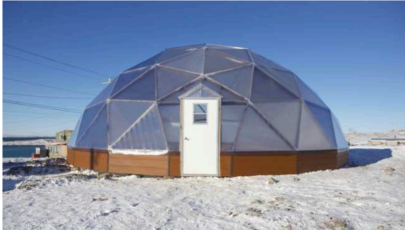
FIGURE 2.10 – Vue extérieure de la serre de Naujaat [54]
