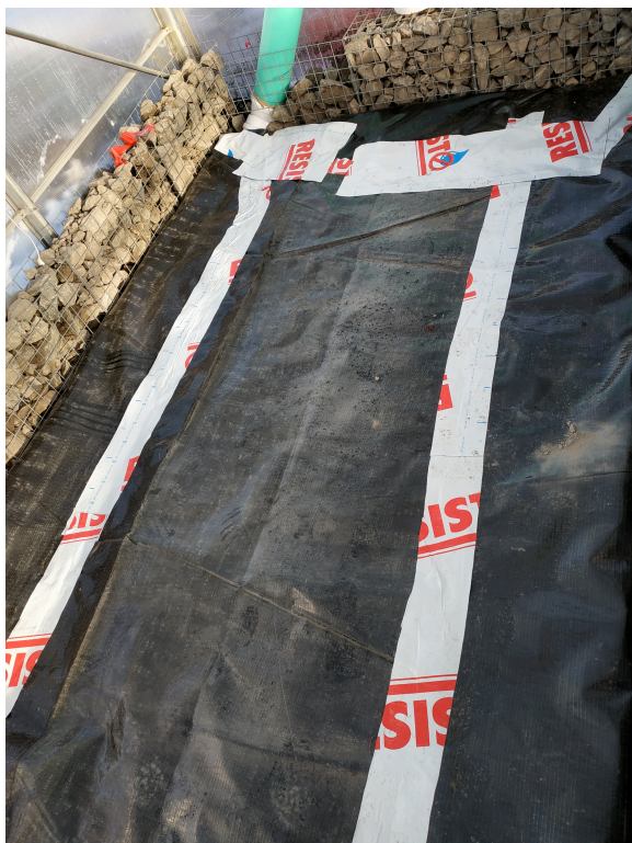
FIGURE 4.11 – Scellement de la bâche
