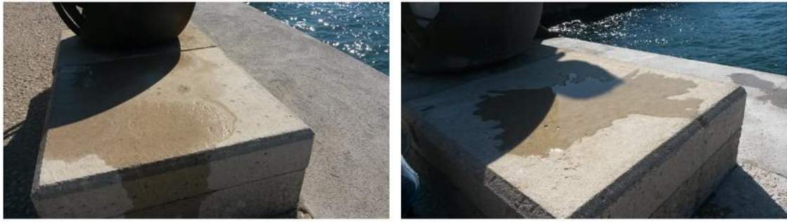
Figure 16 : Gauche : plot de béton non traité ; Droite : plot de béton traité par SCP (photos fournies par SCP avec accord).
