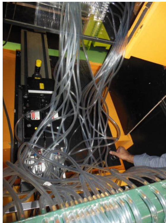
Figure 189 : Chaque tuyau branché sur le Badgir est en même temps branché sur l'appareil de mesure
