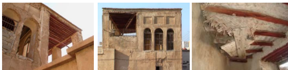
Figure 72 : Toits plats réalisés avec du Chandal, feuilles de palmier et de terre d'argile
