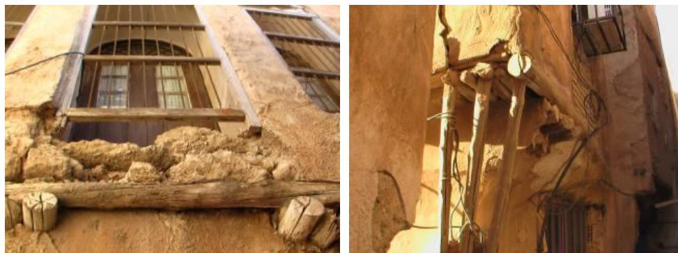
Figure 71 : Chandal (poutres en bois), dans les ruelles de la ville de Bushehr
