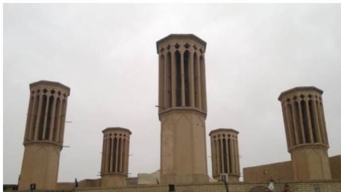
Figure 42 : 5 Badgirs couvrant un réservoir d'eau, Yazd
