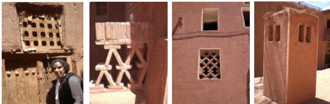
Figure 165 : Écrans perforés permettant le passage rapide du vent ainsi qu'un mini Badgir installé sur un réservoir d'eau (droite)
