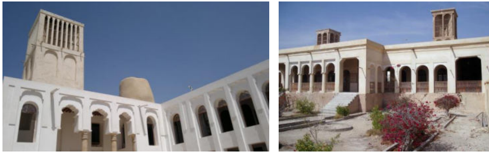
Figure 59 : Maison à un seul Badgir. Maison de Fekri, Bandar Lengeh ; à deux Badgirs
