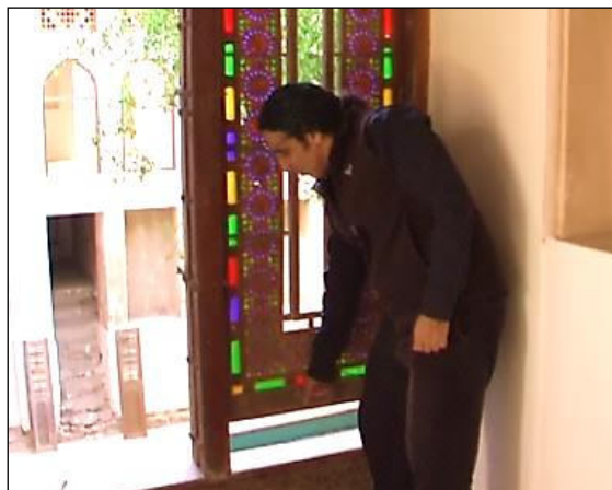
Figure 67 : Fenêtre construite en plusieurs parties distinctes
