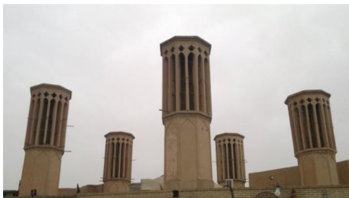
Figure 42 : 5 Badgirs couvrant un réservoir d'eau, Yazd
