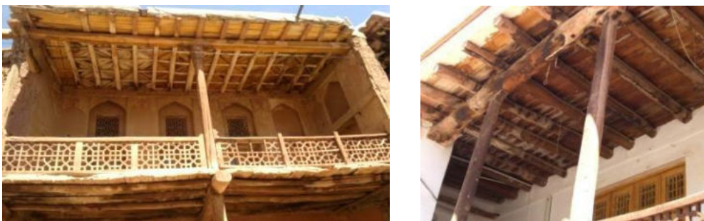
Figure 161 : Balcons et terrasses d'Abyaneh
