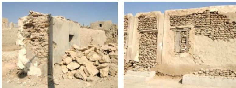
Figure 136 : Pierre avec laquelle a été construite la maison de Nasuri
