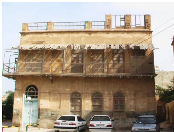
Figure 77 : Texture claire des murs à Bushehr
