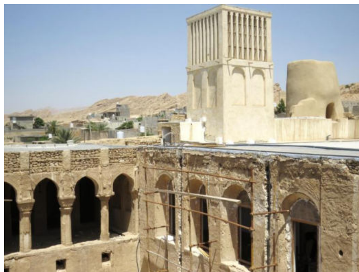
Figure 209 : Badgir de la maison de Nasuri
