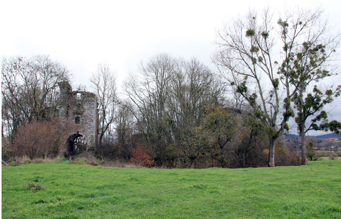
Le château et la tour-porche, vu depuis le sud-est, état actuel (cl. V. Chevassu, 2012).
