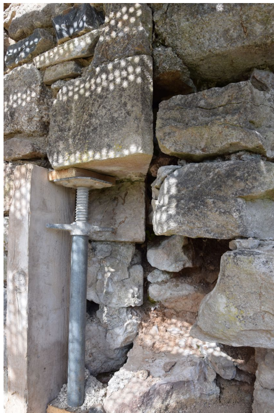
Tour de flanquement sud, premier niveau, archère sud-ouest partiellement dégagée lors des travaux de restauration de 2018 (cl. V. Chevassu, 2018).
