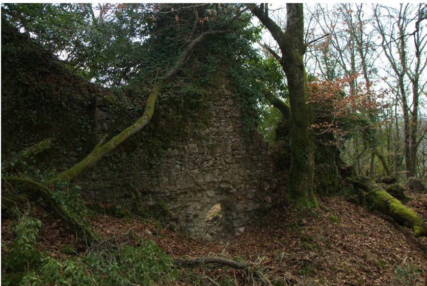
Bâtiment central (XII e s.), parement interne du mur sud et baie en plein cintre (cl. V. Chevassu, 2014).
