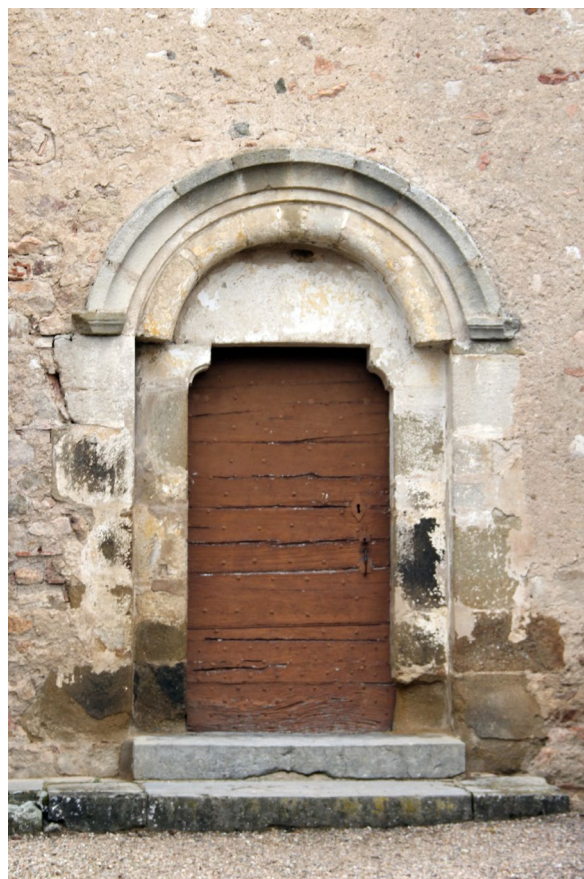
Porte latérale dans le gouttereau sud de la nef, attribuée au XIIIe s. (cl. V. Chevassu, 2012).
