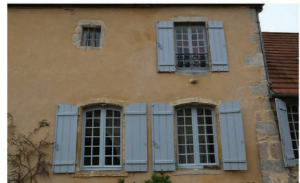
Façade sud : contrefort, baies XVIe et XVIIIe
