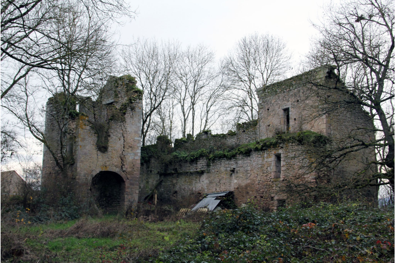
Intérieur de la cour, tour-porche, courtine subsistante avec chemin de ronde et crénelage, tour sud-ouest (cl. V. Chevassu, 2012).
