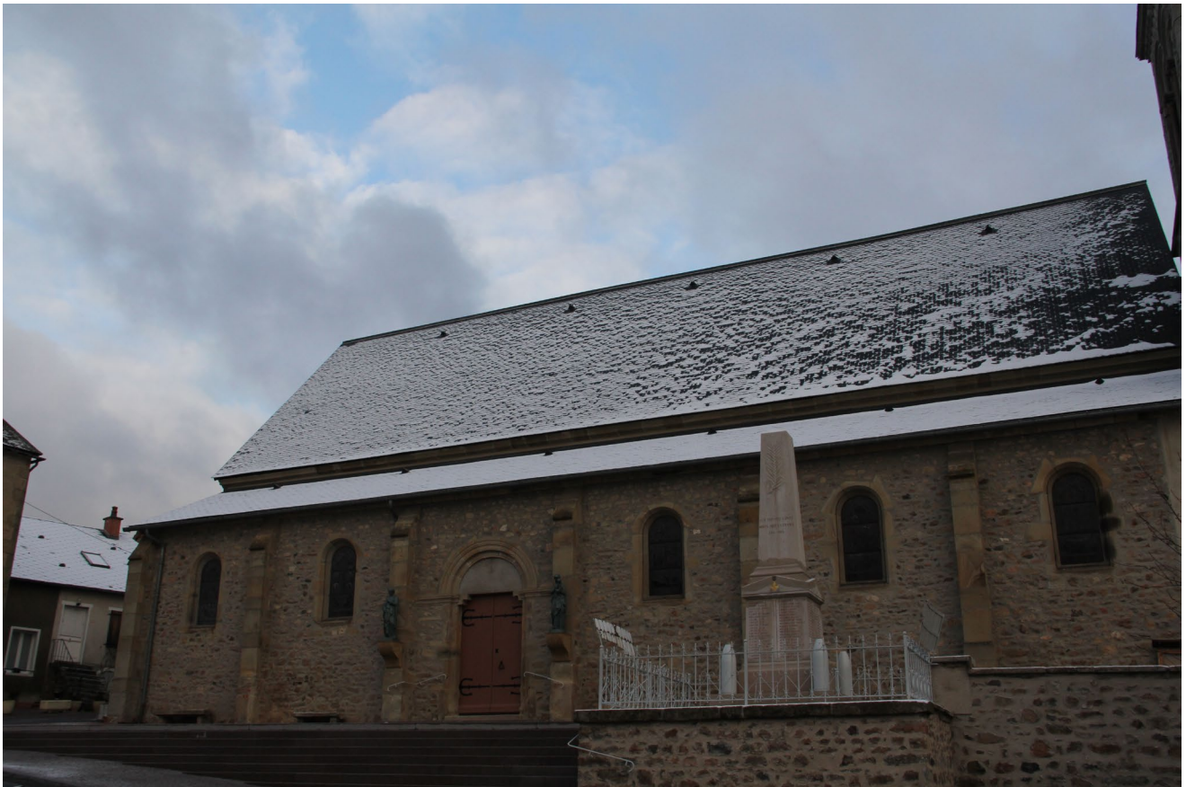
Vue générale de l'église, collatéral sud et entrée latérale (cl. V. Chevassu, 2012).
