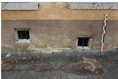
Façade ouest : soupiraux
