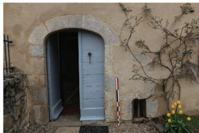
Façade sud : porte et ouverture murée
