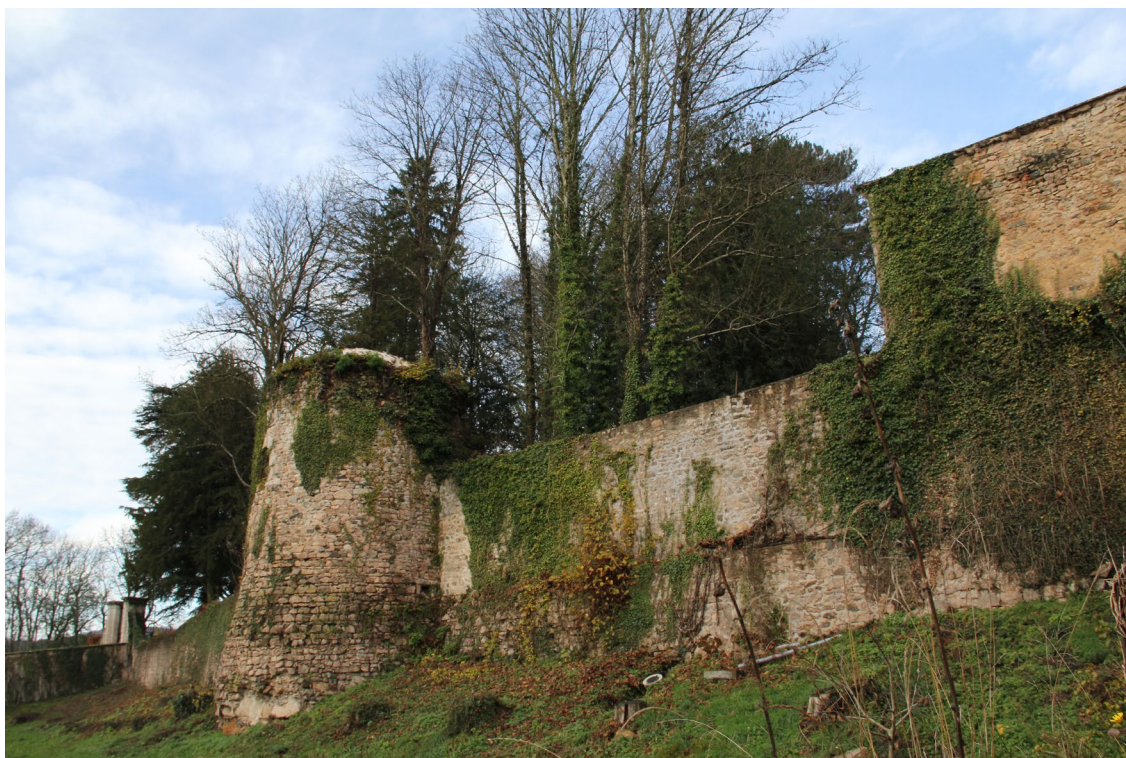
Larochemillay - château de la Roche : l'enceinte médiévale et moderne vue du nord-est (cl. V. Chevassu, 2012).
