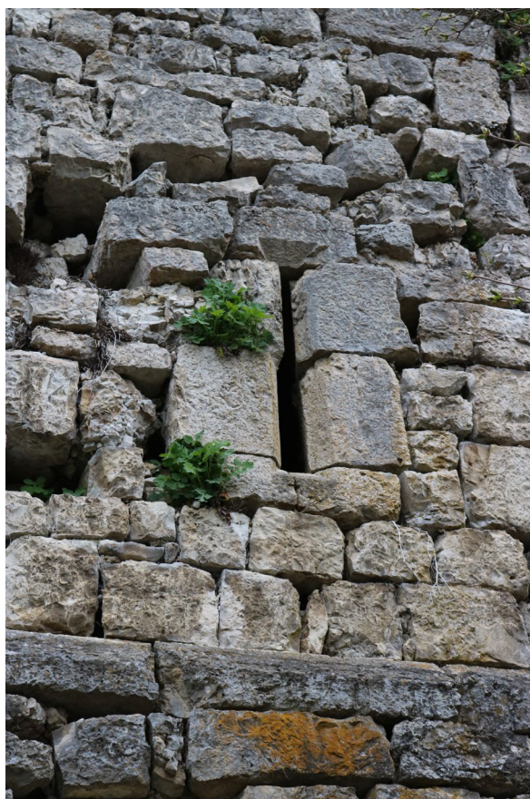
Mur d'enceinte sud-est, archère courte (cl. V. Metral, 2020).
