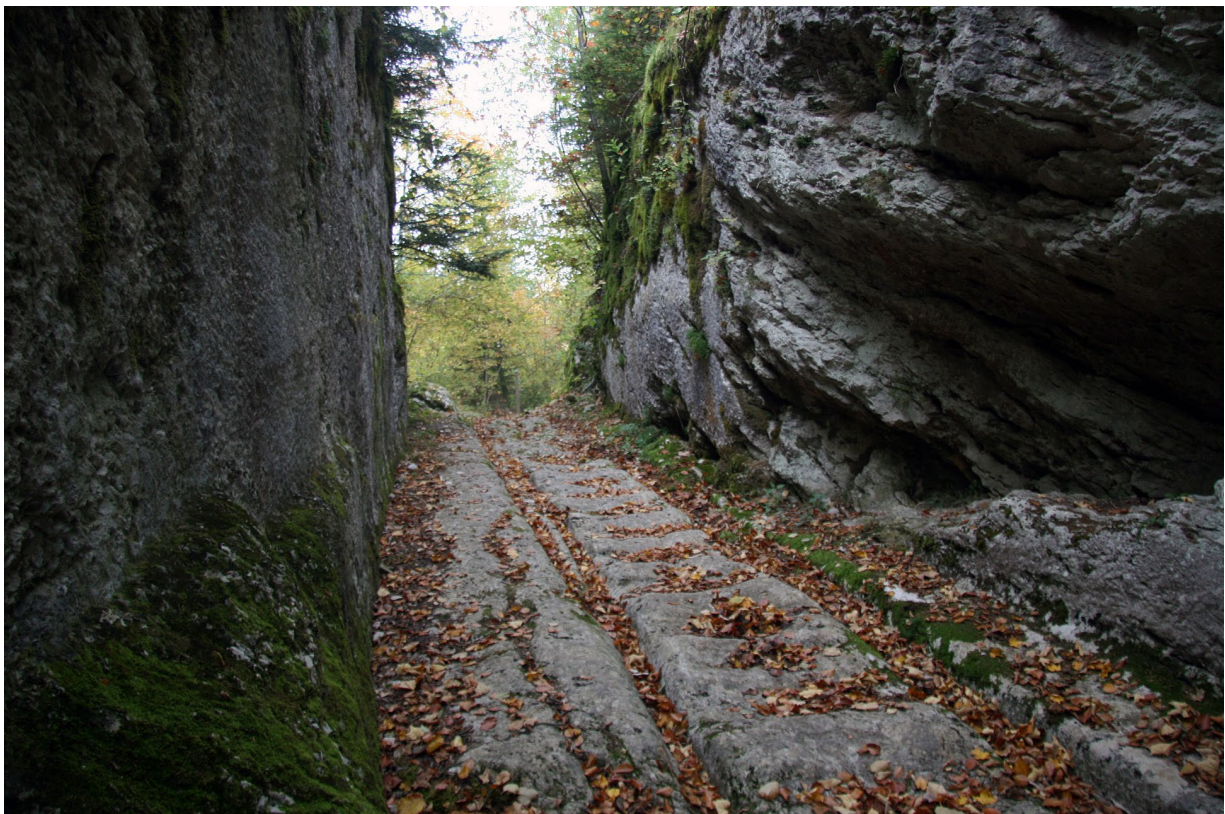
Voie à ornières, emmarchements médians et passage taillé lié à la perception du péage de Chalamont (cl. V. Chevassu, 2015).
