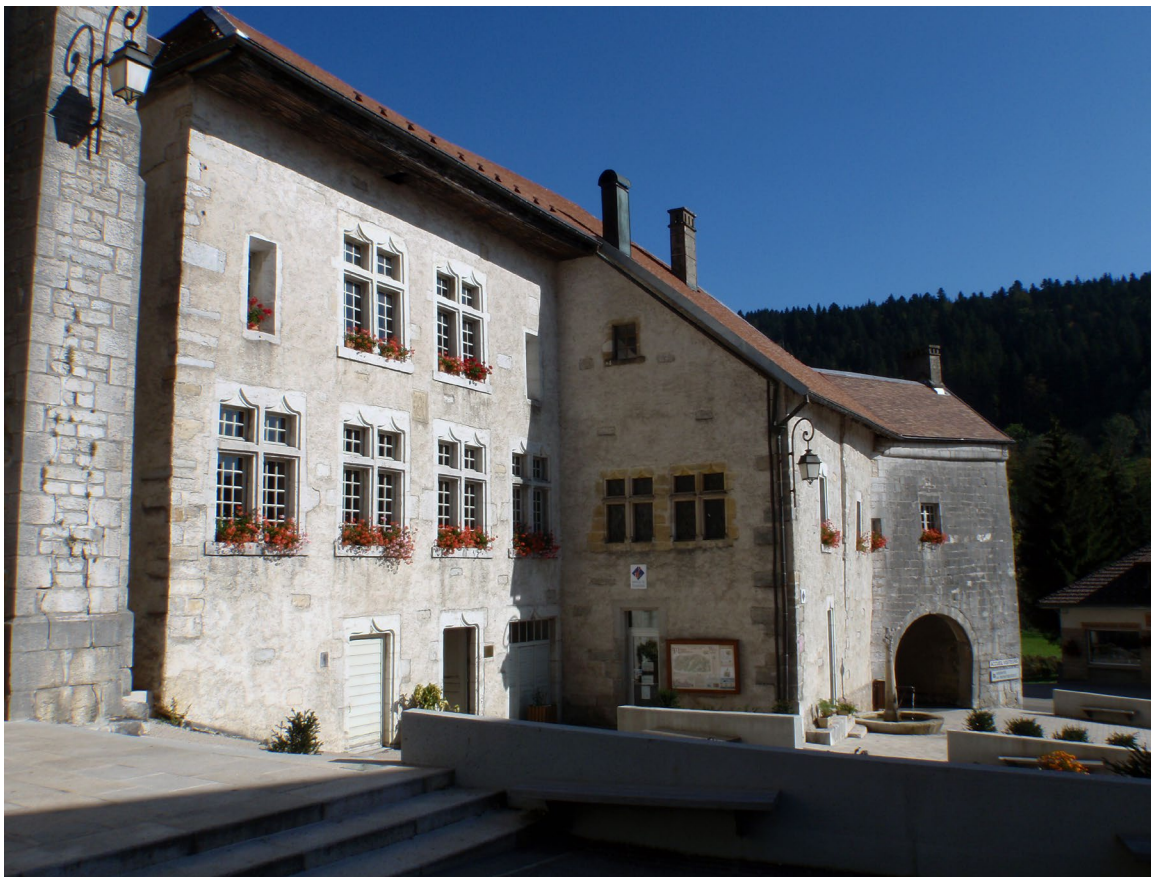
Les bâtiments abbaciaux, façade ouest (cl. V. Chevassu, 2010).
