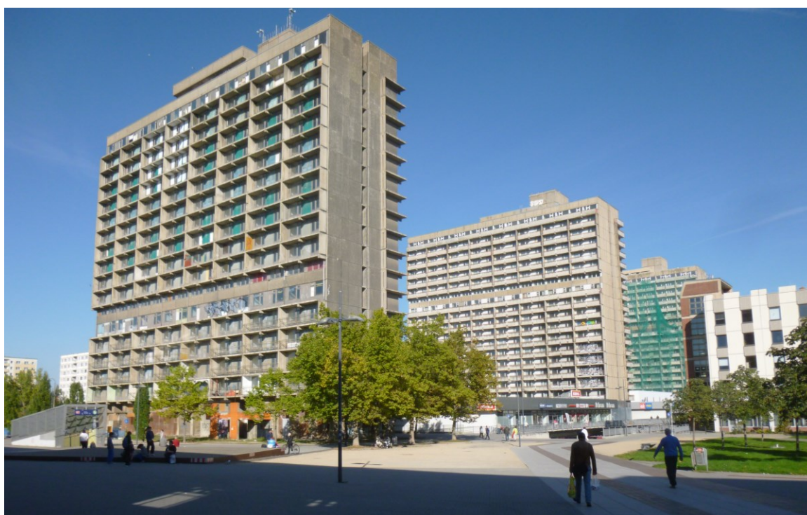
Photo 1 : Les Plattenbauten de Halle-Neustadt – Dubeaux, 2015
