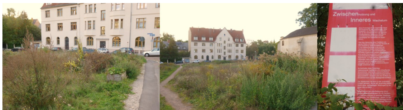
Photo 13 : Les vestiges d'une ZN mise en place dans le cadre de l'IBA dans le centre-ville de Halle, octobre 2015
