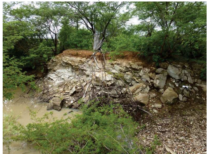
Vue en face du profil – roche saine
