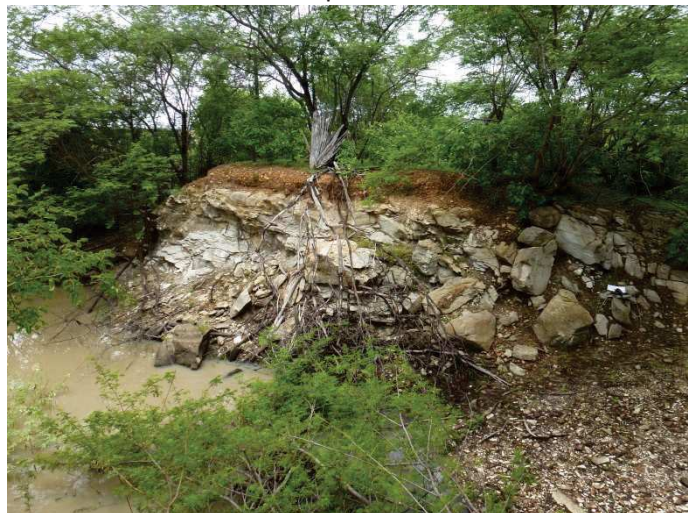
Vue en face du profil – roche saine
