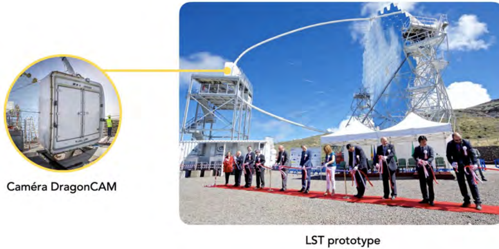
FIGURE 1.30 – La caméra DragonCAM — type de photodétecteur : PMT (©Daniel López / IAC) et l'inauguration du Large-Sized Telescope (LST) — \varnothing : 23 m — poids total avec caméra : 103 T (©Akira Okumura).
