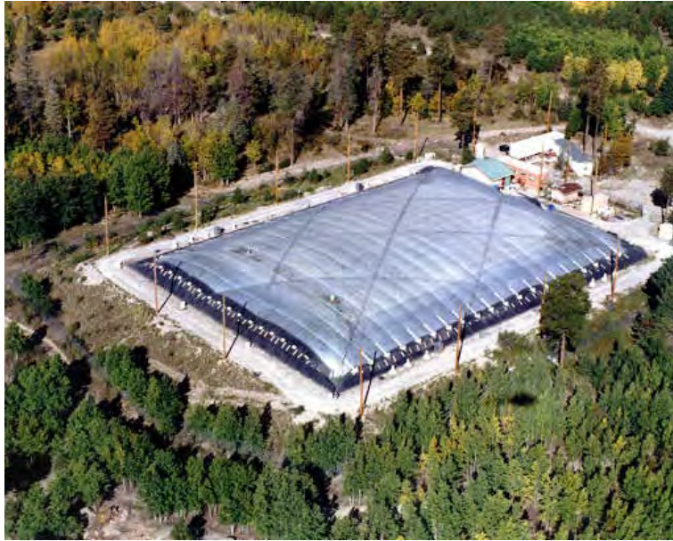
FIGURE 1.12 – Site de MILAGRO, avec couverture stabilisée gonflée pour l'accès ©photo MILAGRO.
