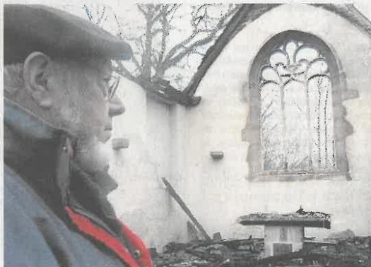
Le maire de Saint-Tugdual ne se laissera pas submerger par l'émotion. Il est d'ores et déjà plongé dans le montage des dossiers nécessaires à la reconstruction de la chapelle Saint-Guen.
