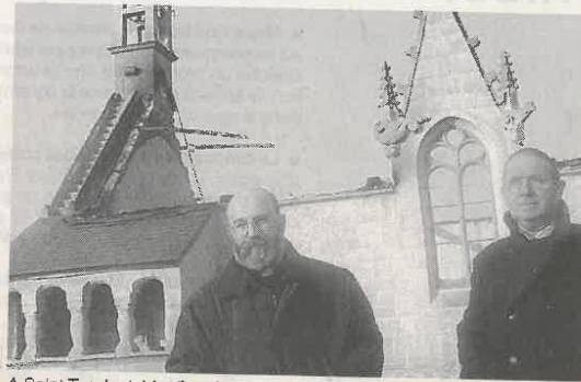
A Saint-Tugdual, Mgr Centène, accompagné du vicaire général, a constaté avec tristesse l'ampleur des dégâts à l'intérieur de la chapelle.
