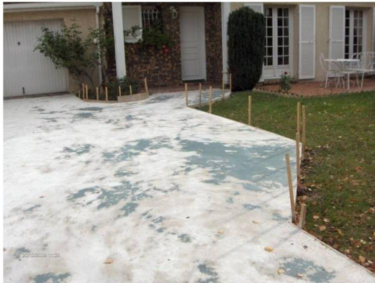
Figure 1.7 : Verdissement observé sur une terrasse à base de ciment au laitier. (Photo : Lafarge)
