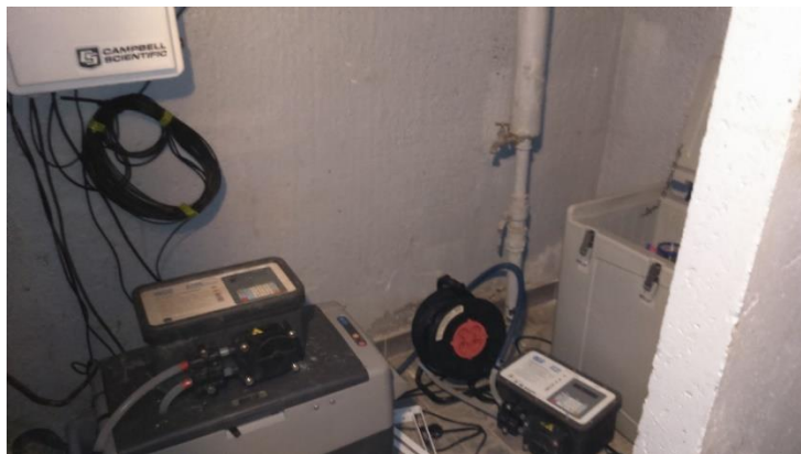
Figure II.29: Système de prélèvement d'un échantillon d'eau sur le parking référence
