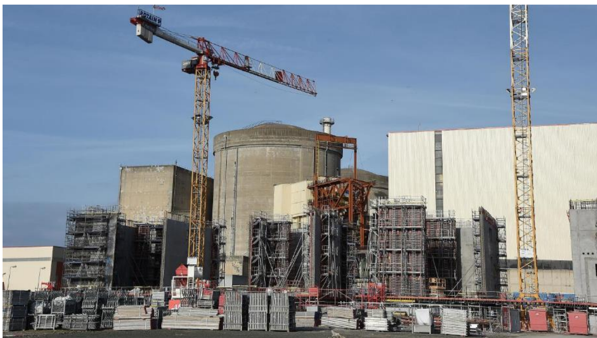
Figure 28: Photo de la construction des Diésels d'ultime secours de la centrale de Gravelines (source : Aïcha Noui, « Gravelines après Fukushima, la centrale construit une forteresse anti-fusion nucléaire », La Voix du Nord , 04/03/2017)
