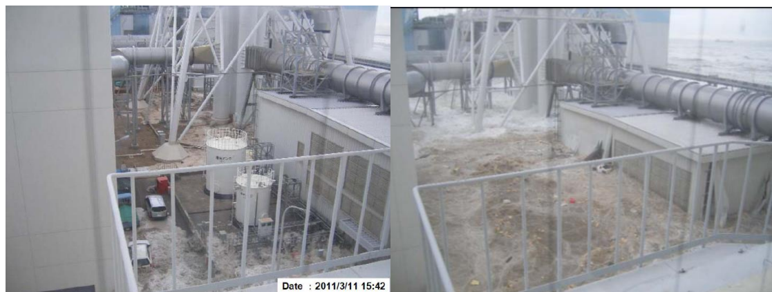
Figure 49 : Inondation de la centrale de Fukushima Daiichi le 11 mars 2011 au moment de l'arrivée de la vague (photo de gauche) et après 74 secondes (photo de droite) (source : TEPCO, "Fukushima Nuclear Accidents Investigation Report", juin 2012, attachement 3.8)
