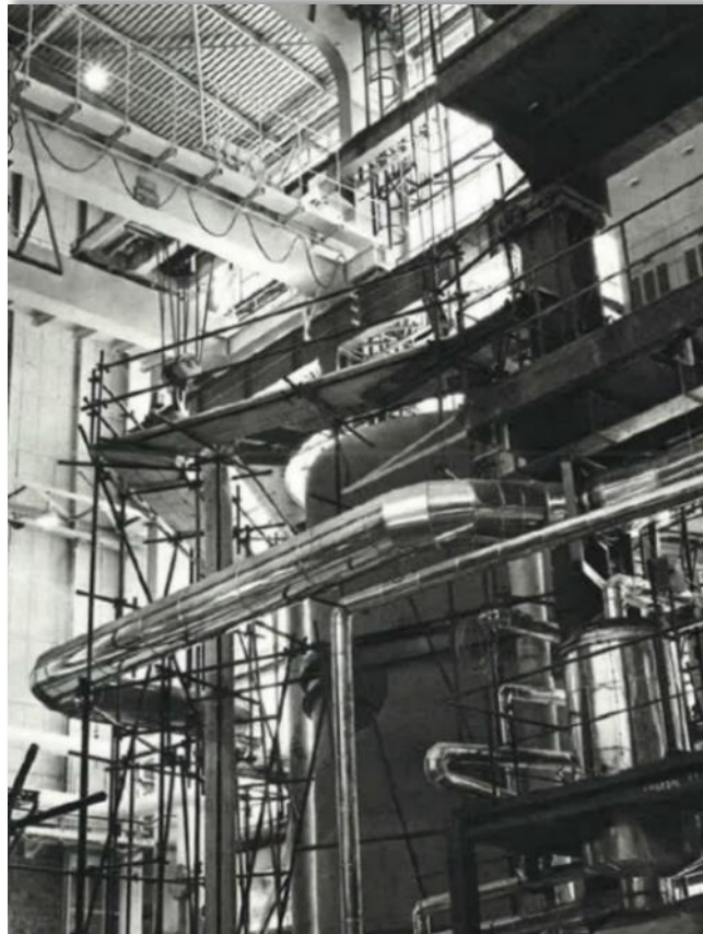
Figure 2: Photo de la maquette échelle 1 du bloc-pile Rapsodie de conception Fives-Penhoët pour essais pression (source : CEA, « Centre d'études nucléaire de Cadarache », date non précisée, p. 38)
