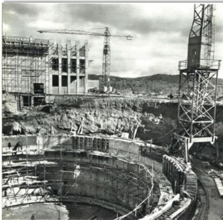
Figure 1 : Construction de l'enceinte de confinement du réacteur Rapsodie en 1963 (source : Brochure CEA, « Centre d'études nucléaire de Cadarache », date non précisée, p. 30)
