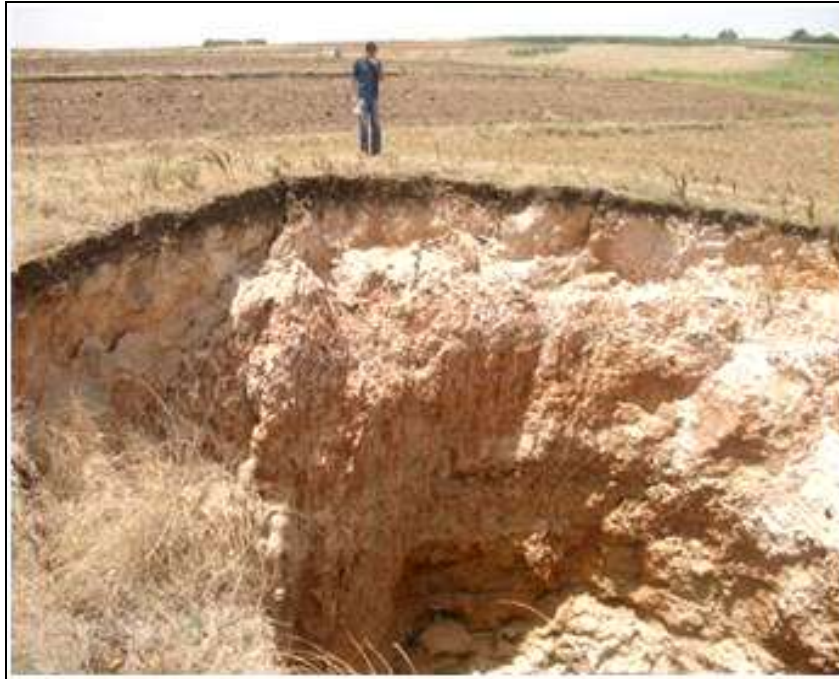
Planche 6 : Photo de l'effondrement Sebt-Saïss (2007) (x : 245.694 ; y : 200.700)
