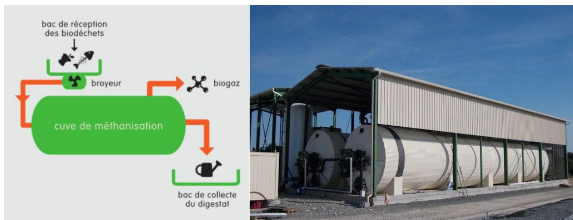
Figure 10 : Schéma du digesteur INEVAL ( ineval.fr ) ; Inneval, GAEC La Lougnolle Auzanneau
