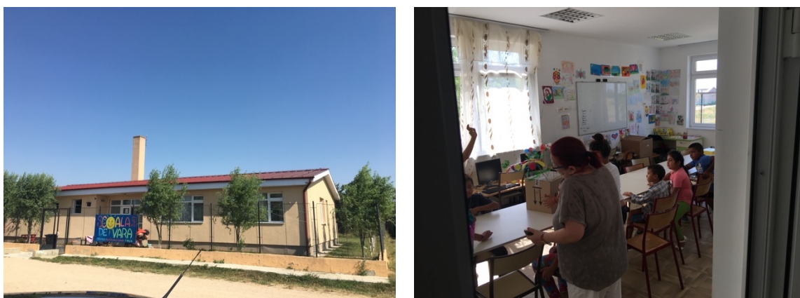
Figures 15-16 - Tinca, Juillet 2017. Intérieur et extérieur du « centre multifonctionnel » financé dans le cadre du projet de coopération décentralisée (Photos de l'auteur)
