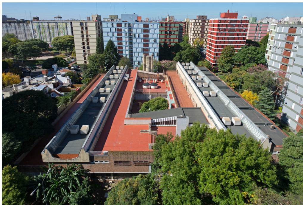
Ilustración 33. Catalinas Sur. Uno de los conjuntos residenciales ya proyectados en el Plano Director, que pudo combinar un interés social con un buen emplazamiento, equipamiento, calidad urbana y paisajística. Foto: Alejandro Goldemberg, para CPAU, Moderna Buenos Aires .
