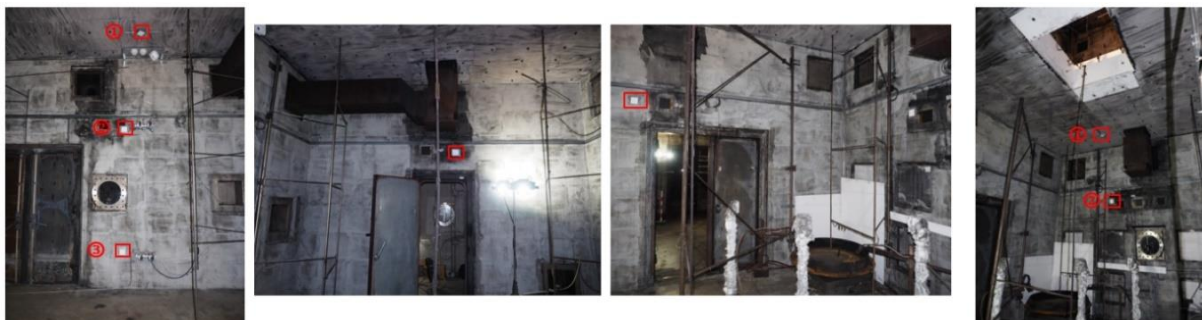
Figure 34 : Cibles installées respectivement sur les parois est, sud, ouest et nord du Local 3 (photos réalisées avant les essais)
