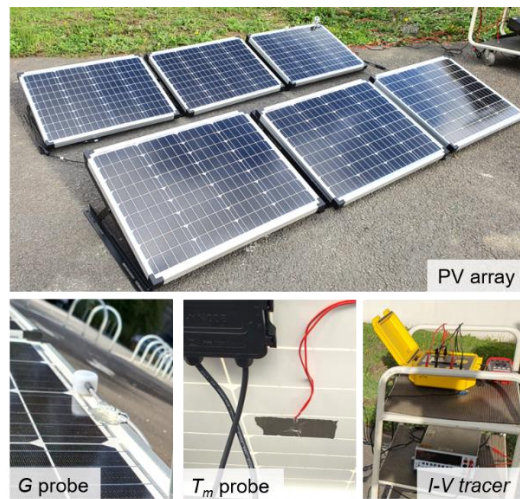
Figure 4: Configuration des tests sur le terrain
