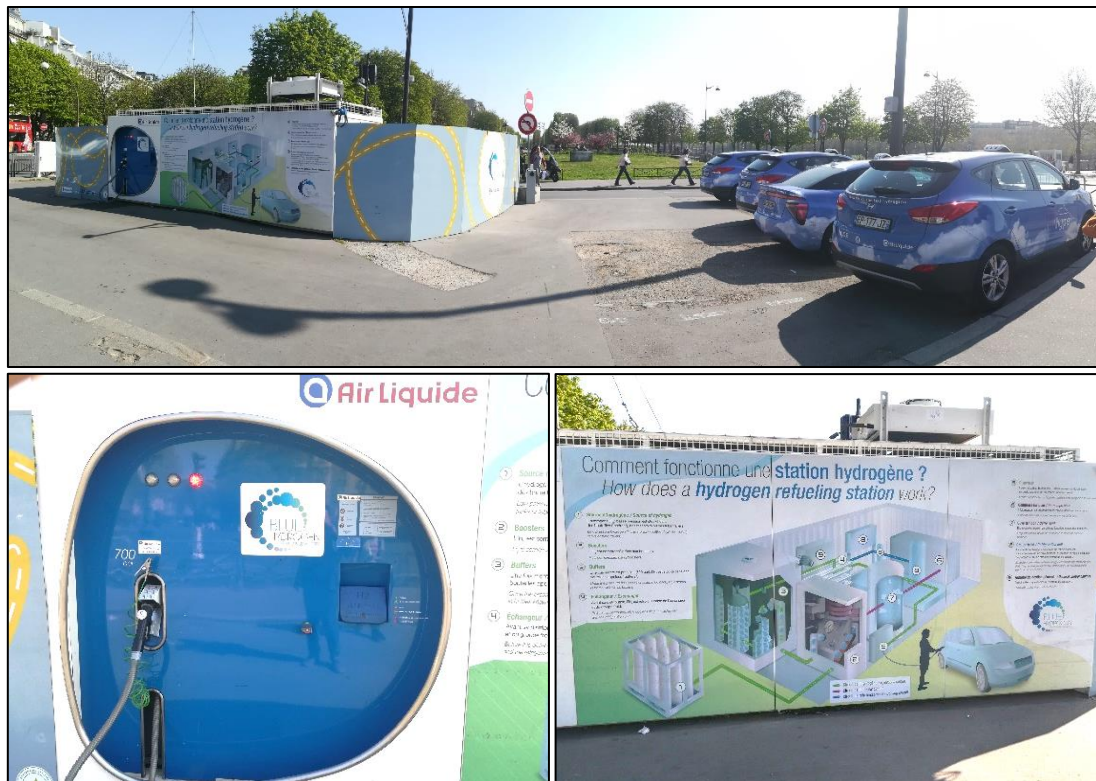
Figure 27: Station de rechargement hydrogène pour une flotte de taxis à hydrogène situé sur Paris.
