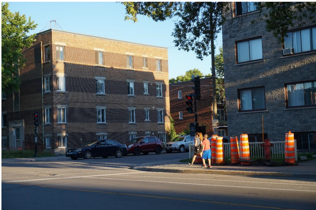
Figure 29 - Une conciergerie dans le nord du quartier à Parc-Extension
