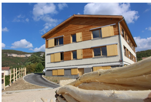
Figure 97 : Le bâtiment de bureaux LowCal (source [293]).
