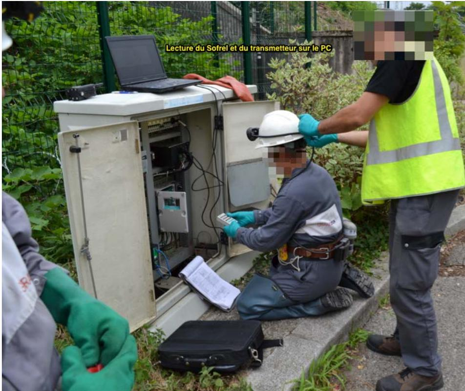
X05 en train de vérifier la correspondance entre l'échelle du Sofrel et l'échelle de l'hydro (le transmetteur)
