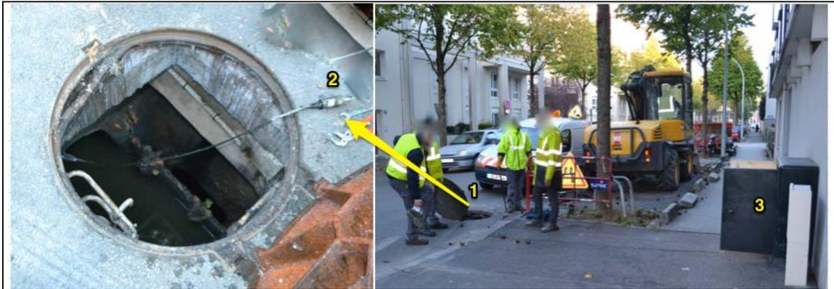
Exemple de site de mesure installé sur un collecteur unitaire non visitable<sup>5</sup> : (1) accès au capteur ; (2) capteur de hauteur ; (3) armoire électrique de commande.
