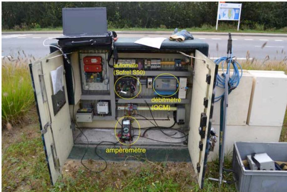
Armoire électrique du site : l'ampèremètre est branché sur la boucle sonde piézo.-Sofrel pour mesurer le signal électrique émis par la sonde.
