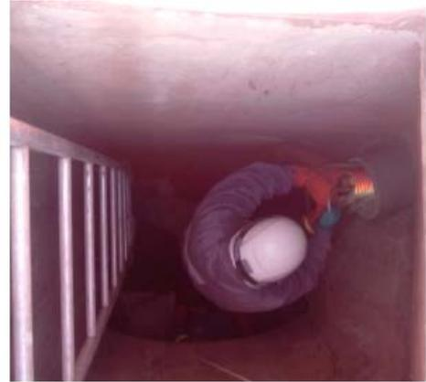
X01[surveillant] (à droite) ; X03 (à gauche) [en bas] en train de tirer les câbles des sondes inopérantes.
