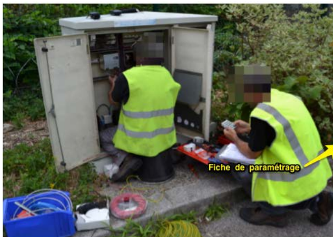
X01 et X03 en train de paramétrer le transmetteur de hauteur
