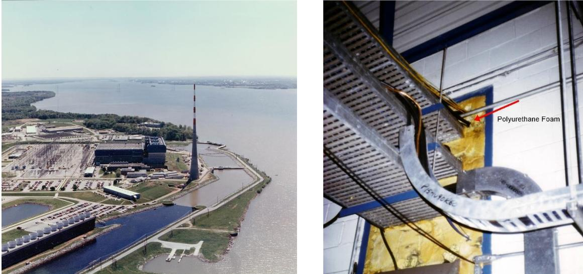
*Fig. 2 : Centrale de Browns Ferry (gauche) et joint d'étanchéité en polyuréthane qui comble le passage de câbles entre les deux bâtiments (droite).*
