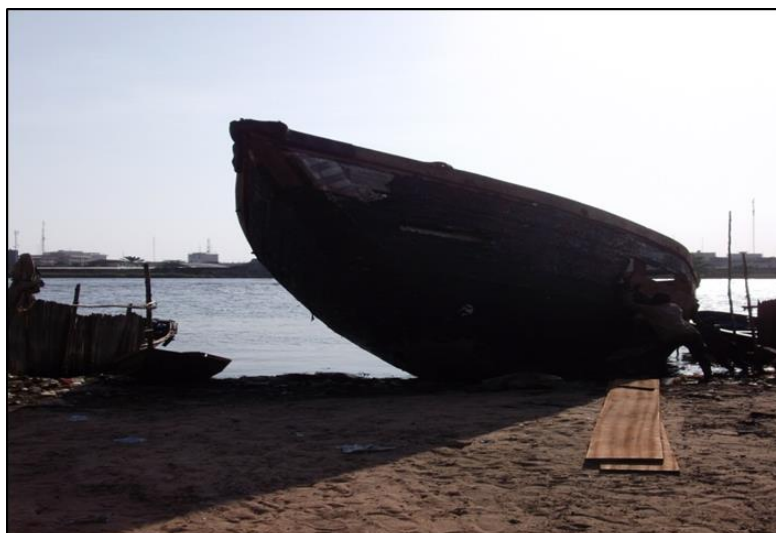
Photo 20 : La réfection de la coque fissurée (2015, cliché AD)
