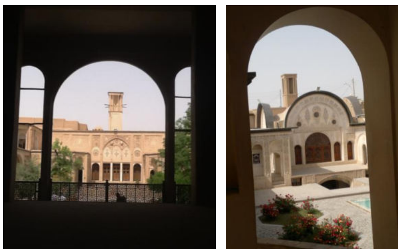
Figure 47 : Façade de deux maisons face au sud possédant des Badgirs à l'arrière
