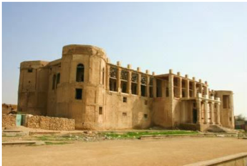
Figure 153 : Château de Malik à Bushehr
