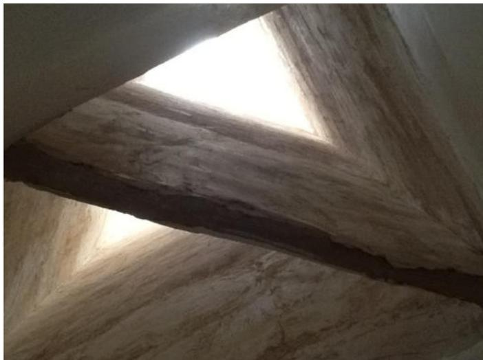
Figure 212 : Lames et conduits du Badgir de Siraf
