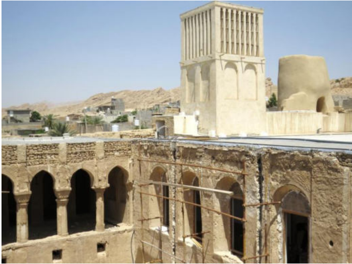
Figure 209 : Badgir de la maison de Nasuri
