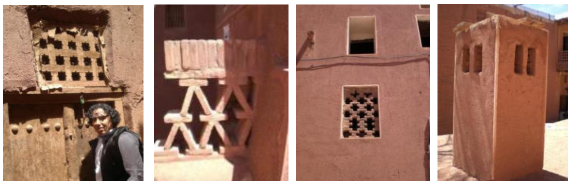
Figure 165 : Écrans perforés permettant le passage rapide du vent ainsi qu'un mini Badgir installé sur un réservoir d'eau (droite)
