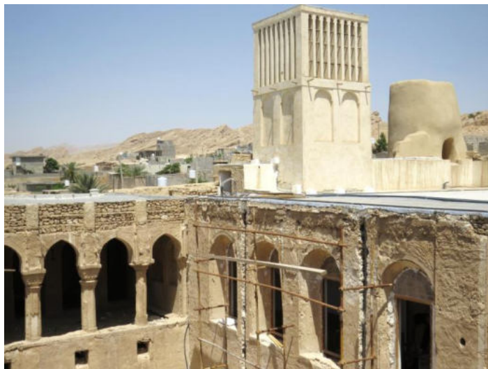
Figure 209 : Badgir de la maison de Nasuri
