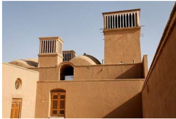
Figure 78 : Badgir construit sur une maison
