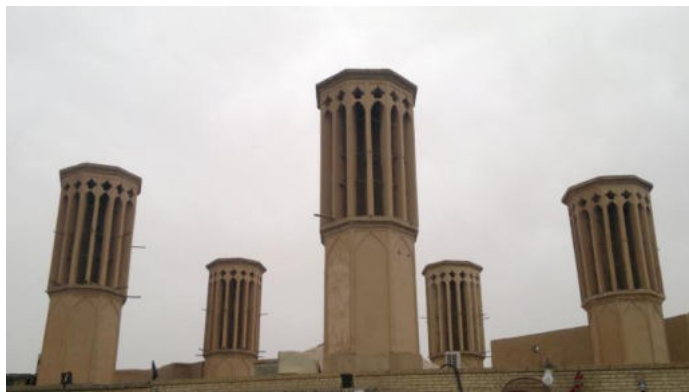
Figure 42 : 5 Badgirs couvrant un réservoir d'eau, Yazd
