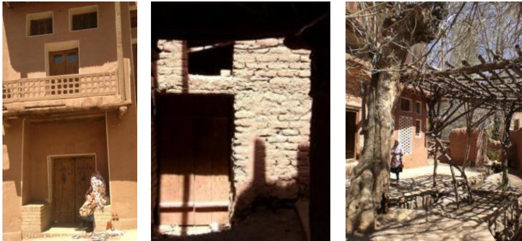
Figure 167 : Création d'ombres et d'espaces frais (photos prises en avril 2013)
