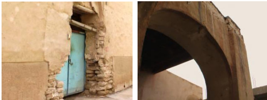
Figures 75 : Murs construits en pierre de mer, épais de 60 à 70 cm
