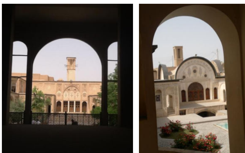
Figure 47 : Façade de deux maisons face au sud possédant des Badgirs à l'arrière
