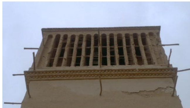
Figure 38 : Les poteaux traversant la structure servaient d'échafaudage et d'entretien du Badgir
