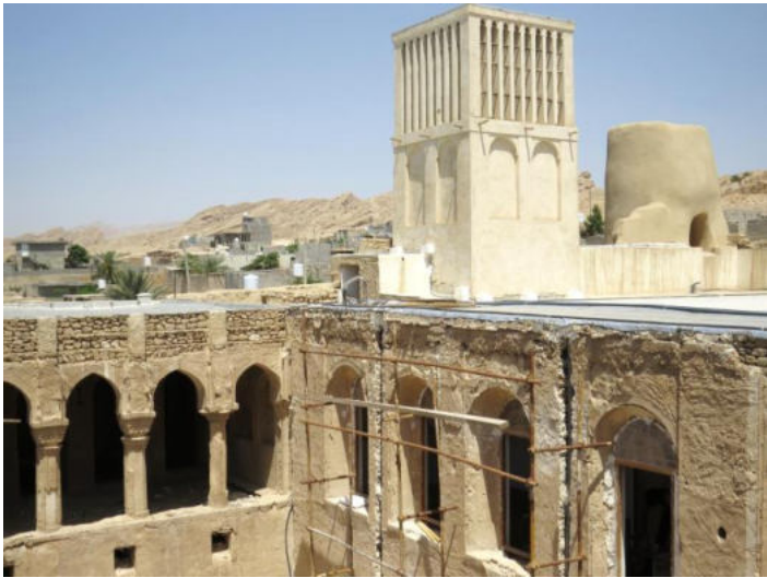
Figure 209 : Badgir de la maison de Nasuri
