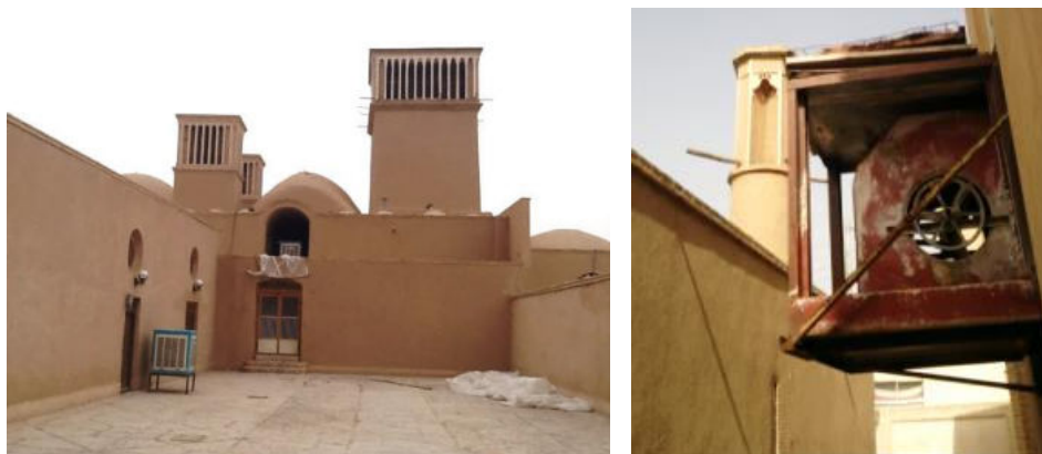
Figure 6 : Des Coolers placés au pied des tours à vent
