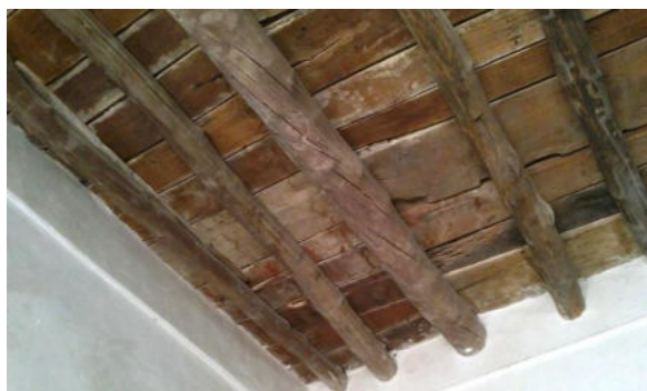
Figure 39 : Poutres en bois utilisés pour la construction des maisons et des Badgirs
