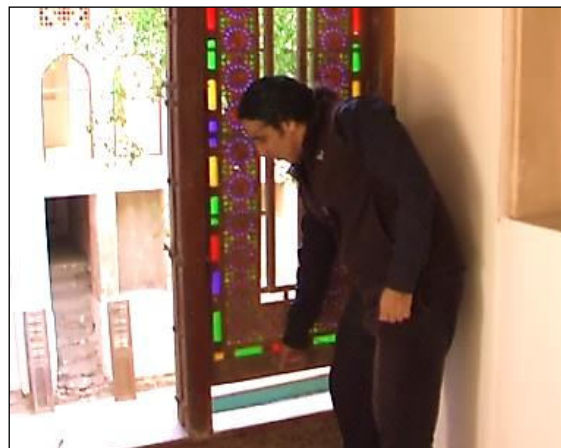
Figure 67 : Fenêtre construite en plusieurs parties distinctes
