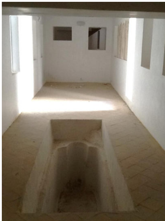
Figure I32 : Fontaine sous le Badgir de la Maison de Nasuri Largeur = 1,14 m, longueur = 3,38 m, profondeur est de 1,53 m Figure I33 : Dimensions des fenêtres
