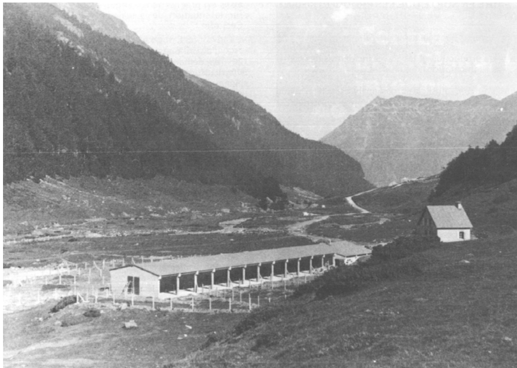
Figure 14 : vue générale d'un centre pastoral (Pâtre n°242, mars 1977)
